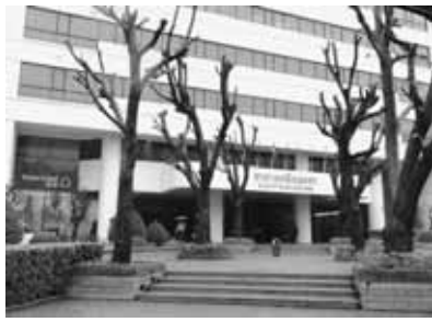
新たな成長策を打ち出すことで事業拡大の足がかりとする(昭和興産タイランドが入居するビル)
